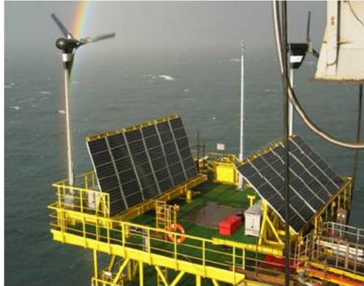
**Figura 7. Plataforma da empresa Shell dotada de sistemas fotovoltaicos e aerogeradores, 2007.**
