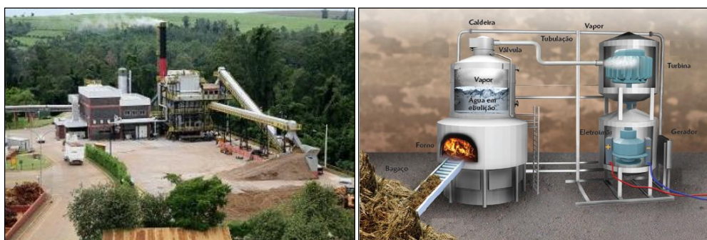
Figura 3 – Exemplos de usinas cogeradoras de energia elétrica a partir do bagaço da cana-de-açúcar
